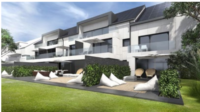
Système intégré Fullblock, les panneaux photovoltaïques assurent l'étanchéité du toit à l'eau. Promoteur: P&P Promotions - Bureau d'études: Joris
