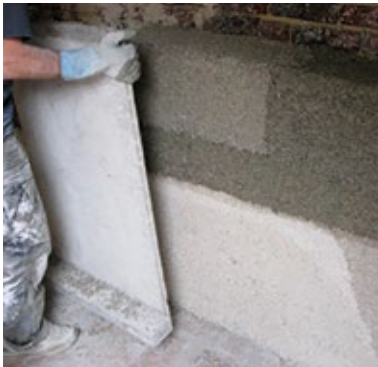
Banchage d’un mélange liant-chanvre pour la réalisation d’un contre-mur
