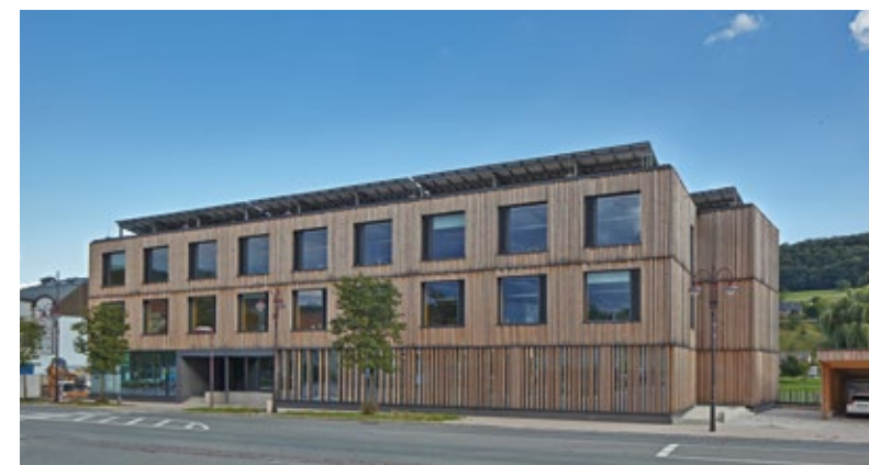
Nördlicher Gebäudeteil mit Lochfassade
