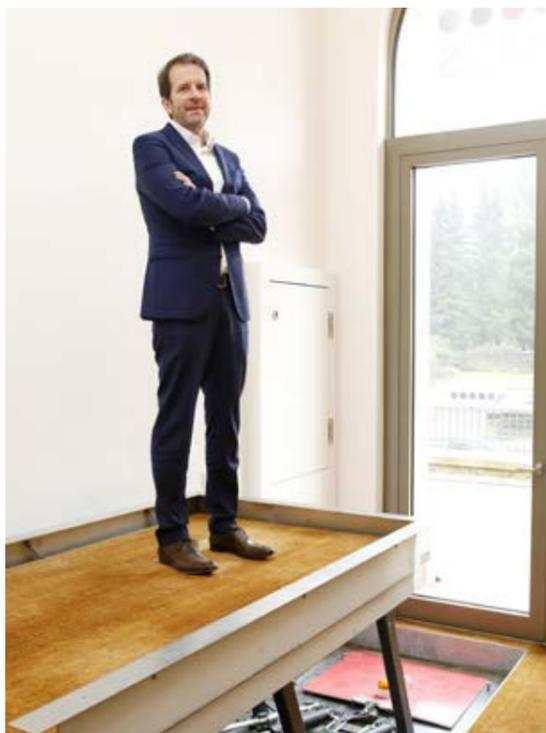
Clément Wampach, La plateforme élévatrice, installée à l'Aalt Stadthaus à Differdange, se déplace d'abord verticalement puis latéralement. Discrète car enterrée, elle est esthétique, peu encombrante et n'entrave pas le passage.
