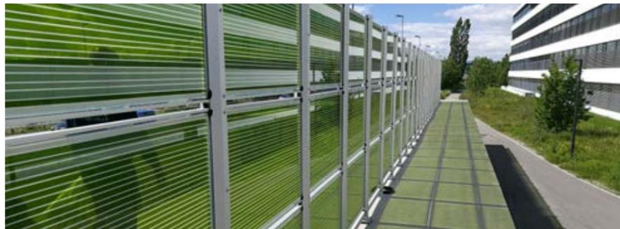
Barrière antibruit qui produit l'énergie fabriquée avec des panneaux de G2E protégeant le bâtiment de Swisscom de la pollution sonore des autoroutes. Le site ouvre de nouvelles possibilités pour la vente des panneaux énergétiques de G2E. Rendement énergétique : 1 012 kWh / an.
