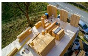
Ce **système constructif bois** prend le contre-pied de la tendance actuelle à préfabriquer de grands éléments pour accélérer la phase de construction sur chantier. Ceux-ci n'étant pas toujours adaptés au travail en milieu exigü, Dom'Inov a conçu un système basé
