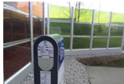
Panneaux de cellules solaires comme source d'alimentation pour une station de charge de voitures électriques sur le site de fabrication de G2E
