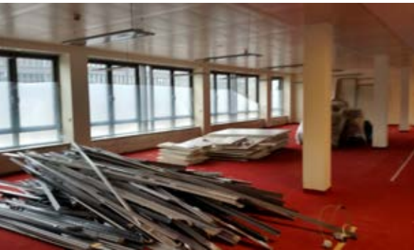
Chantier de déconstruction géré par la société Polygone avec collecte sélective permettant de favoriser la valorisation des matériaux.
